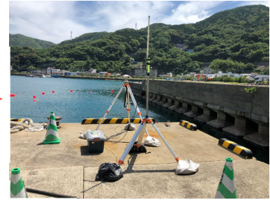
【① RTK-GNSS 陸上基地局】
