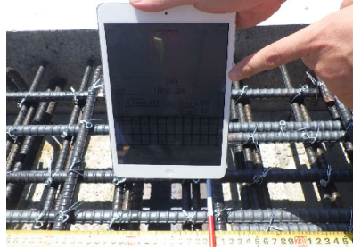
現地でのタブレット端末の画面による出来形確認
