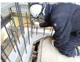
【コンクリート内部温度の確認状況】
