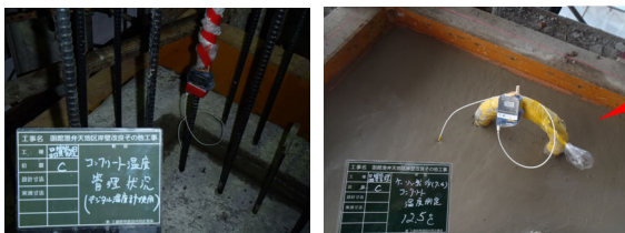
【コンクリート温度計測状況】
