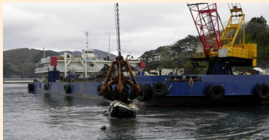
(漁港における航路・泊地等の啓開)
